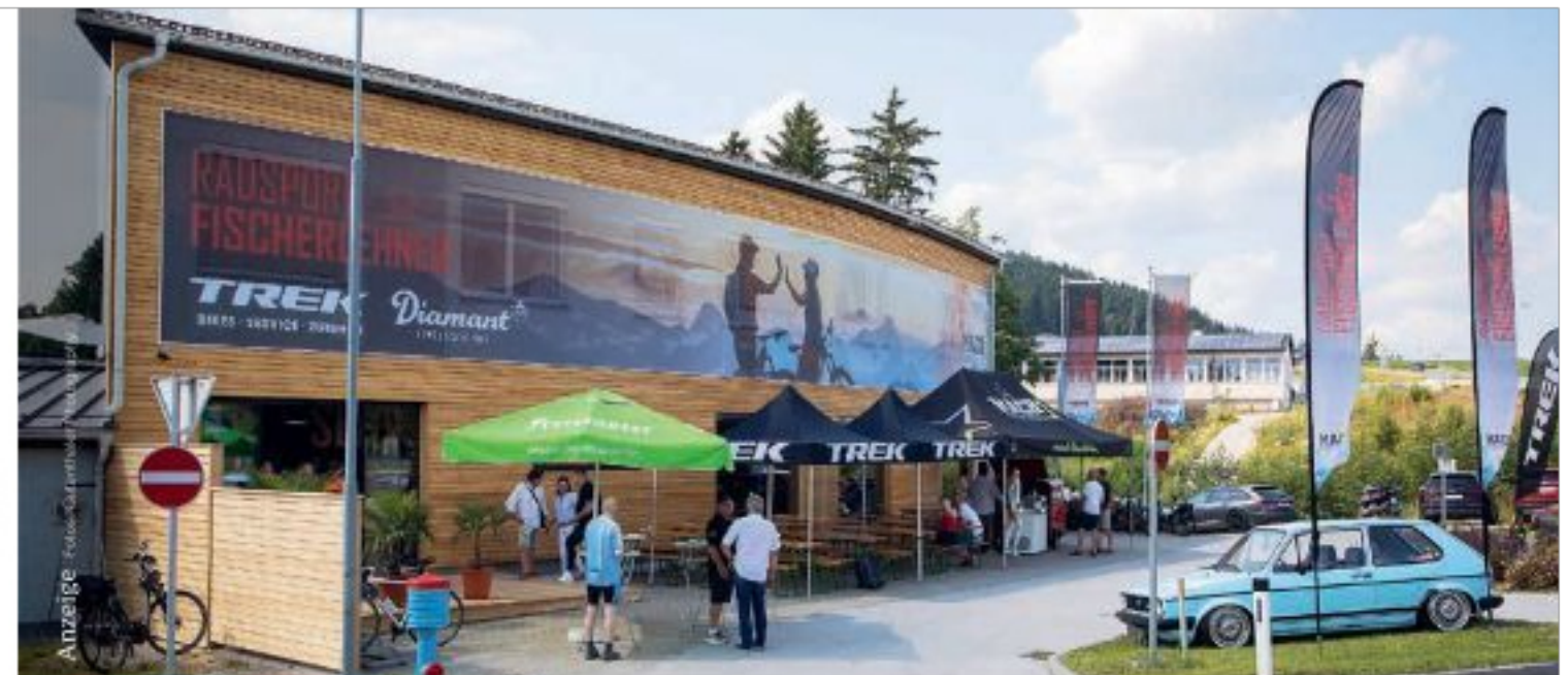
Das bestehende Gebäude wurde innen und außen komplett renoviert. Martin Fischerlehner vertraute dabei ausschließlich auf Firmen aus der Region.
